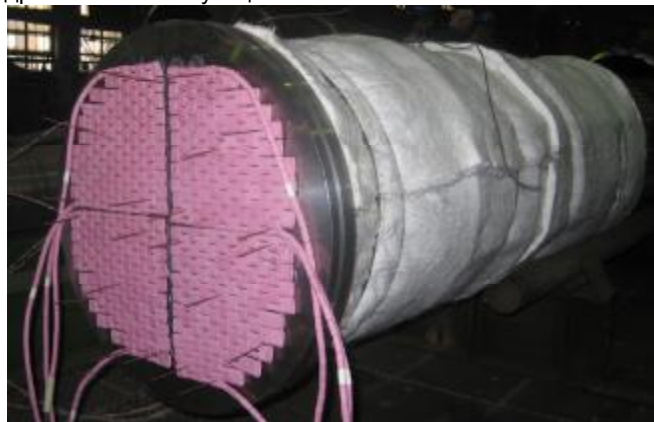
Рис. 16. Термообработка мест приварки труб к трубной решетке
